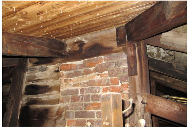
67. Charpente du toit attachée à la cheminée, 2020 (LuceLafontaineArchitectes)
